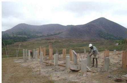
Installation d'une nouvelle charpente sur le toit du centre (tout en haut) et les fondations de la nouvelle cuisine-réfectoire (ci-dessus). Des structures en bois sur pilotis sont recommandées pour améliorer la ventilation naturelle et demeurer fraîche malgré le climat tropical, sans avoir besoin de recourir à l'air conditionné. Le bois dur utilisé pour la construction provient de concessions forestières au Gabon certifiée par le Forest Stewardship Council (FSC).
